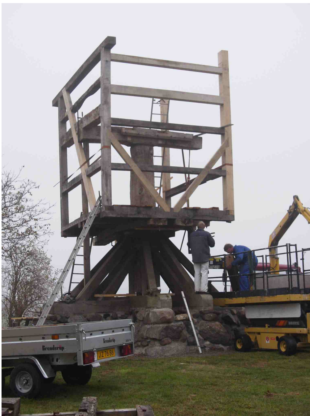
Møllehuset afklædt. Hjørnestolper, skråbånd m.v. under istandsættelse.
